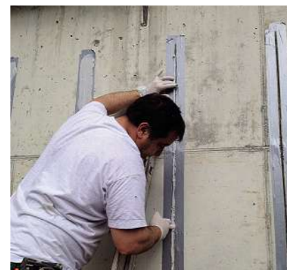
2 Slot-applied S&P C-Laminate (Bending)
